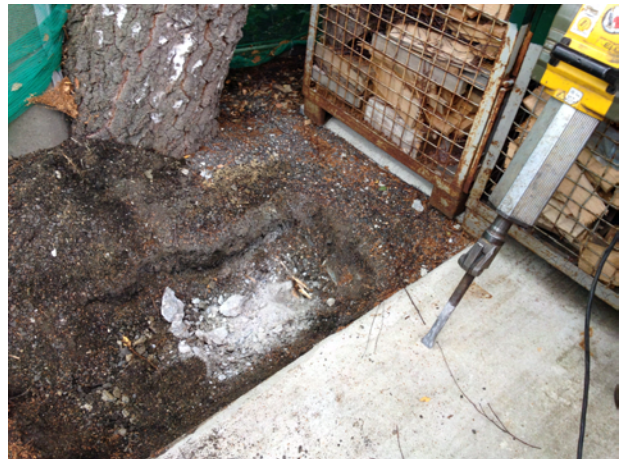
Unter einem bodenähnlichen Substrat sind Betonplatten anzutreffen und darunter Beton oder Beton-Recyclingmaterial
