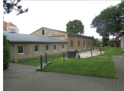
Turnhalle Grundschule, gepl. Abriss
